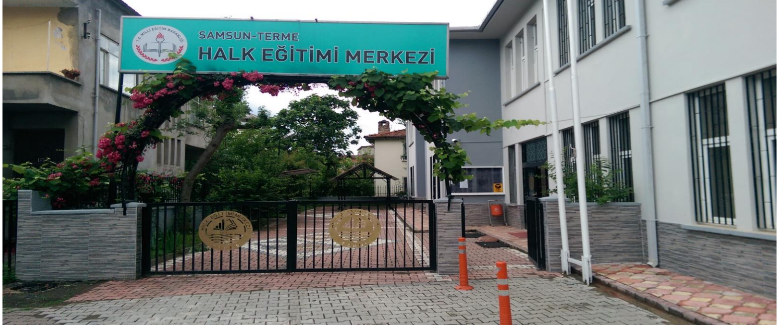
Merkez Binamız Dış Görünüşü
